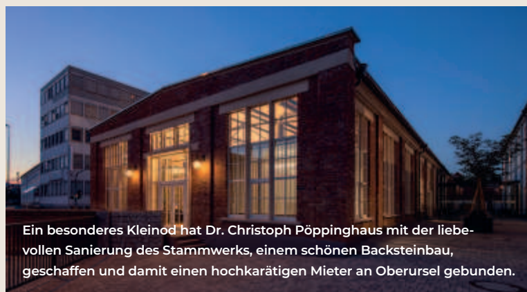
Die alte Industriearchitektur der Gebäude ist noch immer gut zu erkennen.
